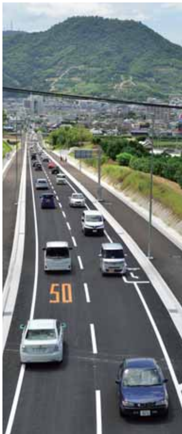
高松市西部の東西幹線の 開通でより交流が深まる ＝峰山トンネルから
