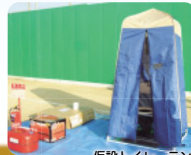
仮設トイレ、テント付
